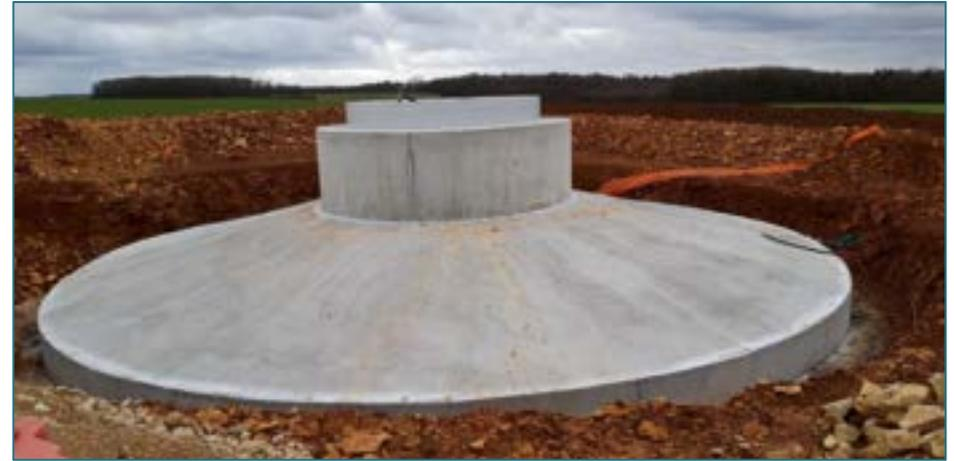
*Coulage du béton de la fondation – environ 305 à 325 m<sup>3</sup>*
