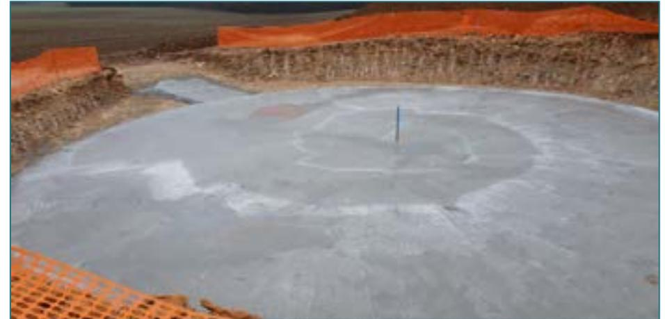
*Préparation de la fondation – creusage du trou et assise – 19,5 m de diamètre*
